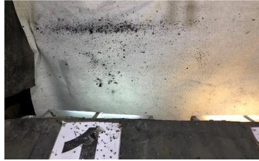
Les photos ci-dessus montrent des impacts dans les bandes de caoutchouc, il faut noter que celles-ci servent de protection et sont 55 cm plus hautes que le centre de l'escargot (piège à balles). Les traces se trouvant sur le géotextile illustrent bien les tirs sur la partie supérieure de l'escargot. Ceci entraîne inévitablement des projections tous azimuts étant donné que le projectile s'écrase sur de l'acier au lieu de pénétrer dans l'escargot comme souhaité.
